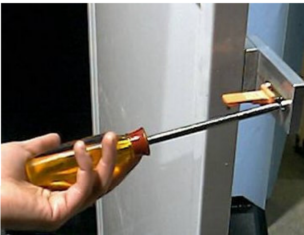
FIG. 12- ADJUST INTERLOCK KEY TAB IF NECESSARY
